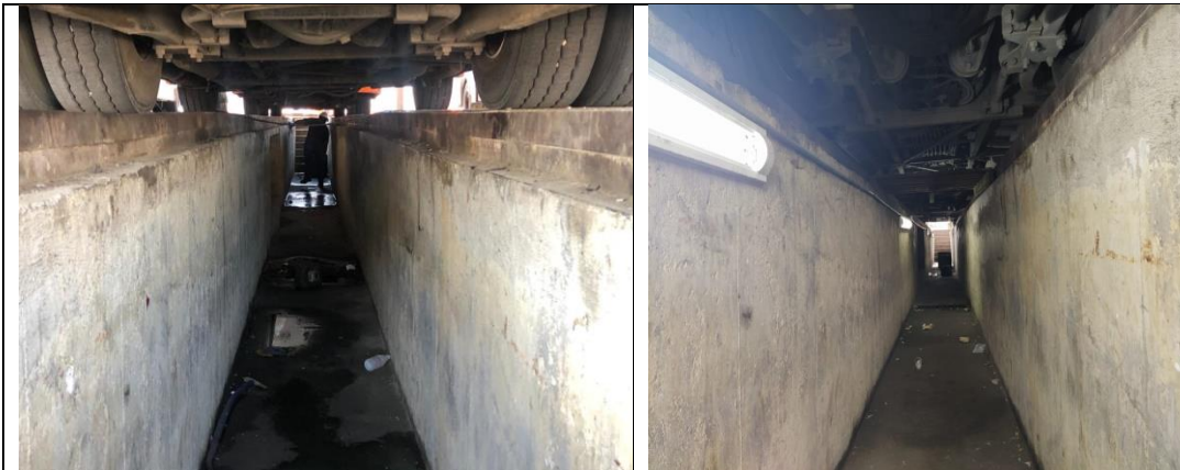
INSTALACION DE ILUMINACION DE CARCAMOS DE MANTENIMIENTO
